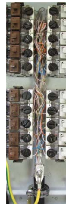
Рисунок 9 – Выкладка пучков подключенных жил введенного кабеля
