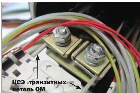
**8** «Транзитные» петли ОМ уложить на металлический кронштейн (со стороны установки кассеты К24-4525) и закрепить их стяжками (кроме ОМ, подлежащего дальнейшему монтажу) рисунки «а» и «б».
