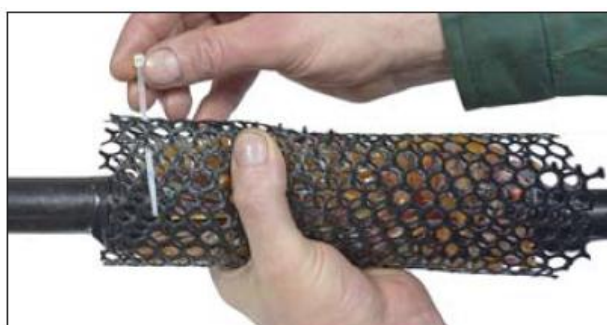
Рис. 5. Установка сетки на срезок и скрепление её стяжками.
