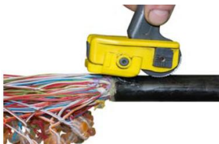
Рис. 2. Выполнение разрезов оболочки ножом KMS-K.
