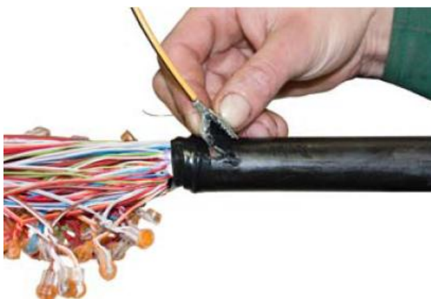
Рис. 4. Установка зажима ПСЭ на «лепесток».
