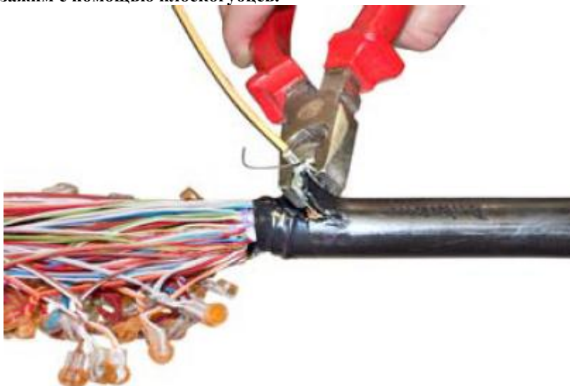
Рис. 5. Сжатие зажима с помощью плоскогубцев.
