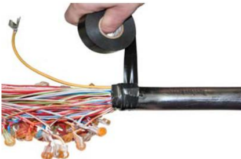
Рис. 6.Наложения бандажа на зажим и оболочку кабеля.
