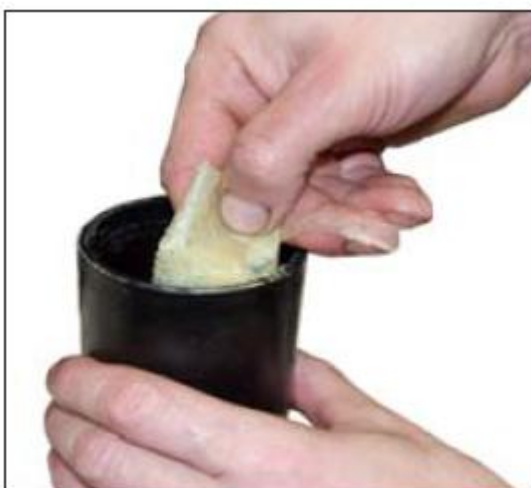
Рис. 1. Смазка внутренних поверхностей гидрофобным наполнителем кабеля.
