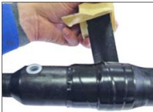
Рис. 12.Намотка ленты VM на стык полумуфты и гильзы МГРг.
