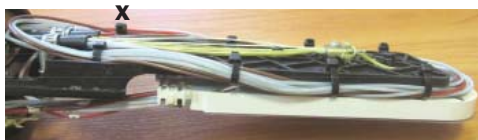
X – место фиксации «транзитных» петель ОМ на металлическом кронштейне
